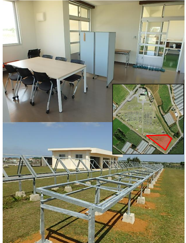
図5 南側設備（来場者用作業室・全景）
